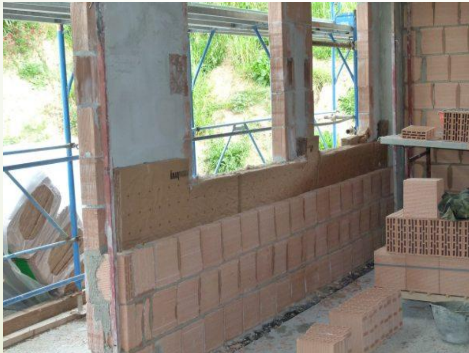
Lana di vetro su parete perimetrale esterna
